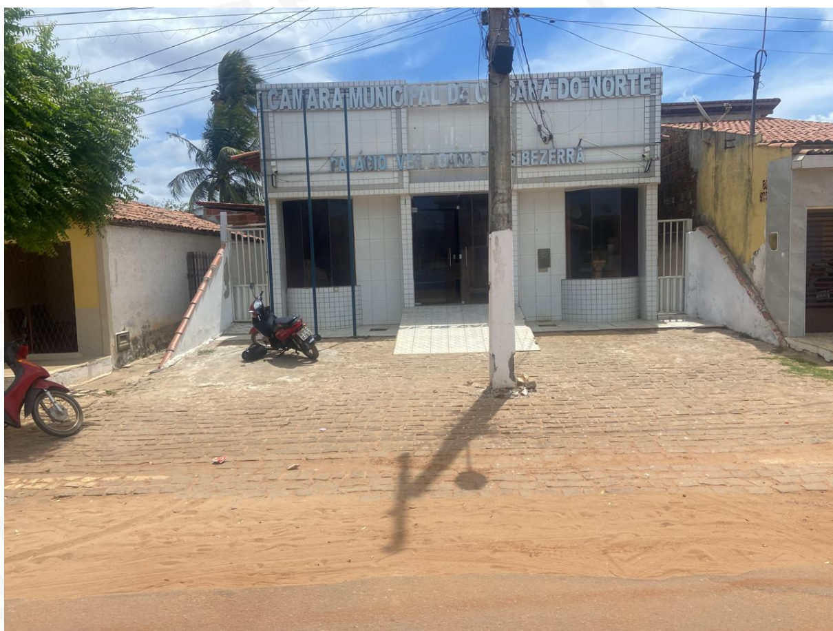
Figura 2: Localização da Edificação da Câmara do município de Caiçara do Norte RN Fonte: Autores, 2025.
